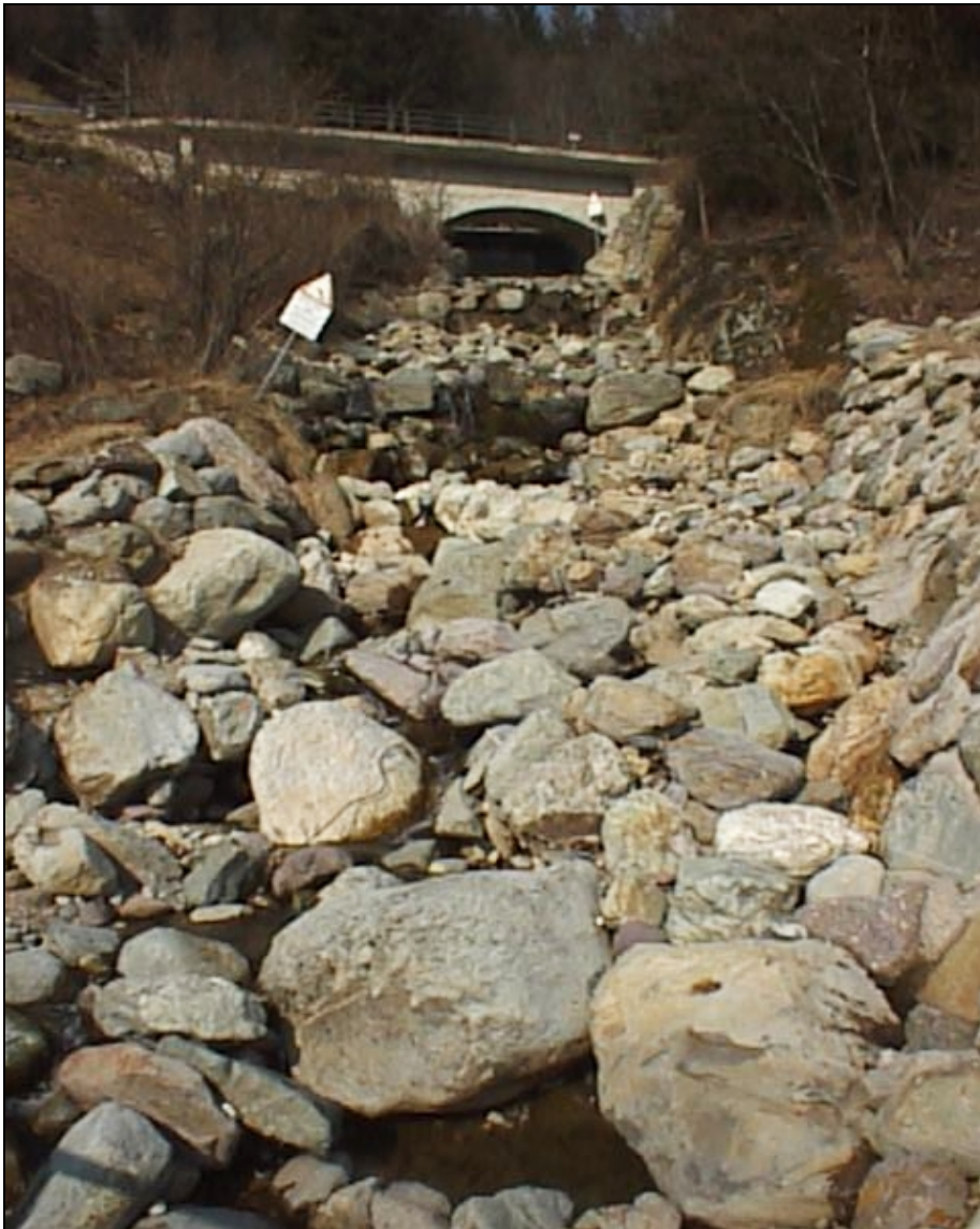
Fig. 25 - Grandi quantità di materiale detritico nell'alveo del T. Ré nell'attraversamento dell'abitato di Valgoglio.
