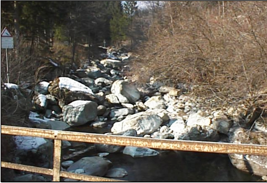
Fig. 24 - Evidenti indizi di mobilitazione in massa di cospicui elementi detritici lungo l'alveo del T. Goglio presso il ponte di Colarete.
