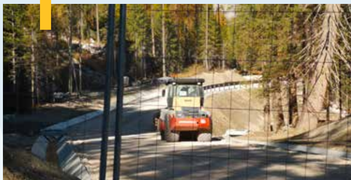
CANTIERE NEL BOSCO, CORTINA © FABIO TULLIO
